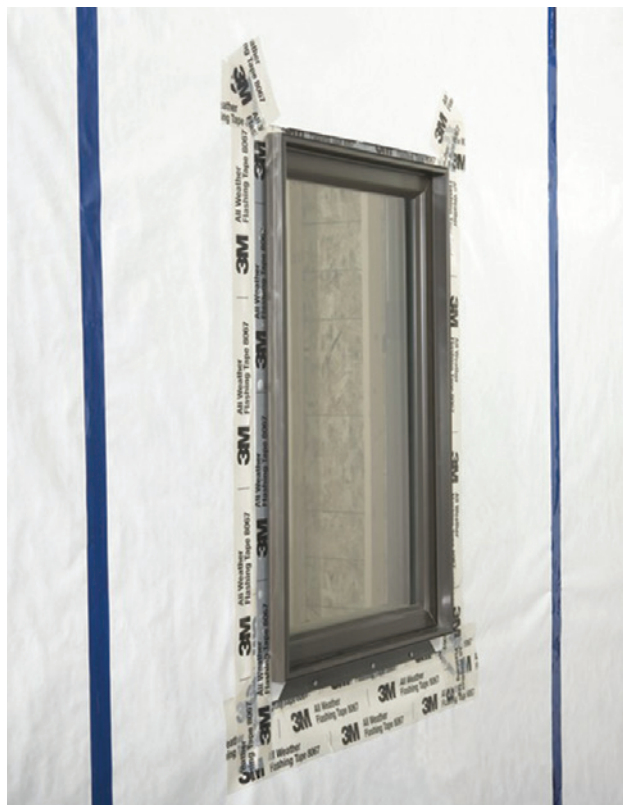
Taśma 3M™ 8067/8777, odporna na warunki pogodowe, samoprzylepna i wodoodporna membrana do uszczelniania przestrzeni wokół stolarki otworowej i przepustów w ścianach zewnętrznych budynków.
