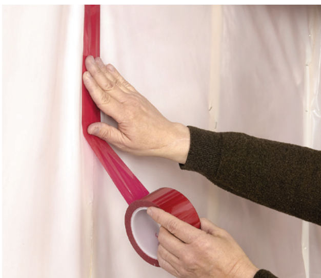
Taśma 3M™ 8087 do łączenia włókien, membran i innych materiałów wewnątrz i na zewnątrz budynków, w pracach naprawczych, uszczelnianiu, itp.
